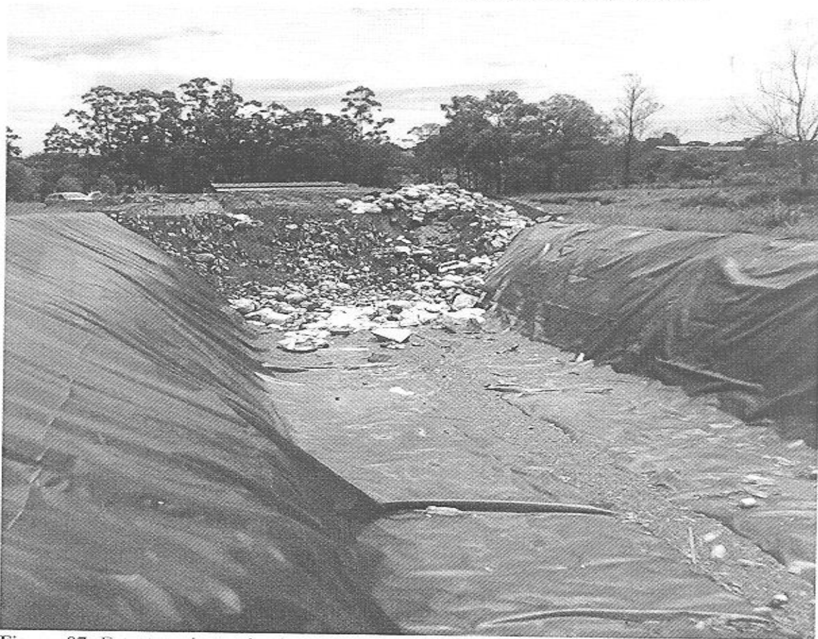
Figura 07- Estrutura da atual vala do aterro sanitário.
